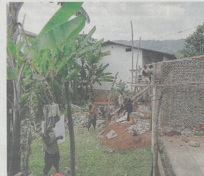
Al lavoro. Operai al lavoro a Kiremba, cittadina in Burundi
